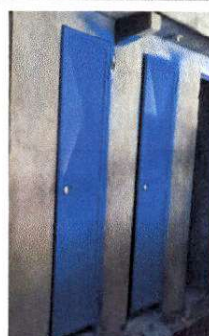
Foto 4: Sustrucción de puerta en servicios sanitarios.
