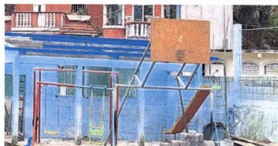
Foto 6: Sustrucción de estructura de soporte de madera por metal y sustrucción de lámina
