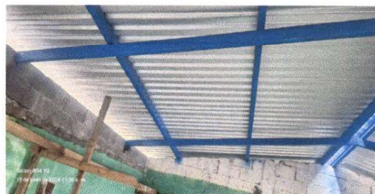
Foto 2: Sustrucción de estructura de soporte de madera por metal y sustrucción de lámina
