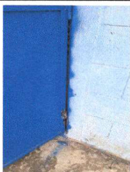
Foto 3: Mantenimiento de estructura lijado, cepillado y aplicación de pintura.
